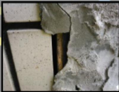
そのパテ塗りされた一部が壊れて、隙間が露になっています。
